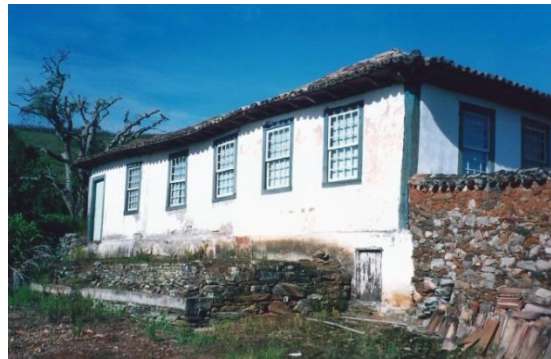
Fig. 2 – Sede da Fazenda do Registro Velho, fachada lateral. Situação em 29.12.2005. Foto: Alessandro Borsagli. Fonte: Acervo de Alessandro Borsagli.
