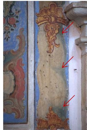
Figura 8: Coluna com terço inferior torço, do retábulo lateral evangelho (central). Autoria: Tainá de Keller e Costa. Data: 21/07/2021.
